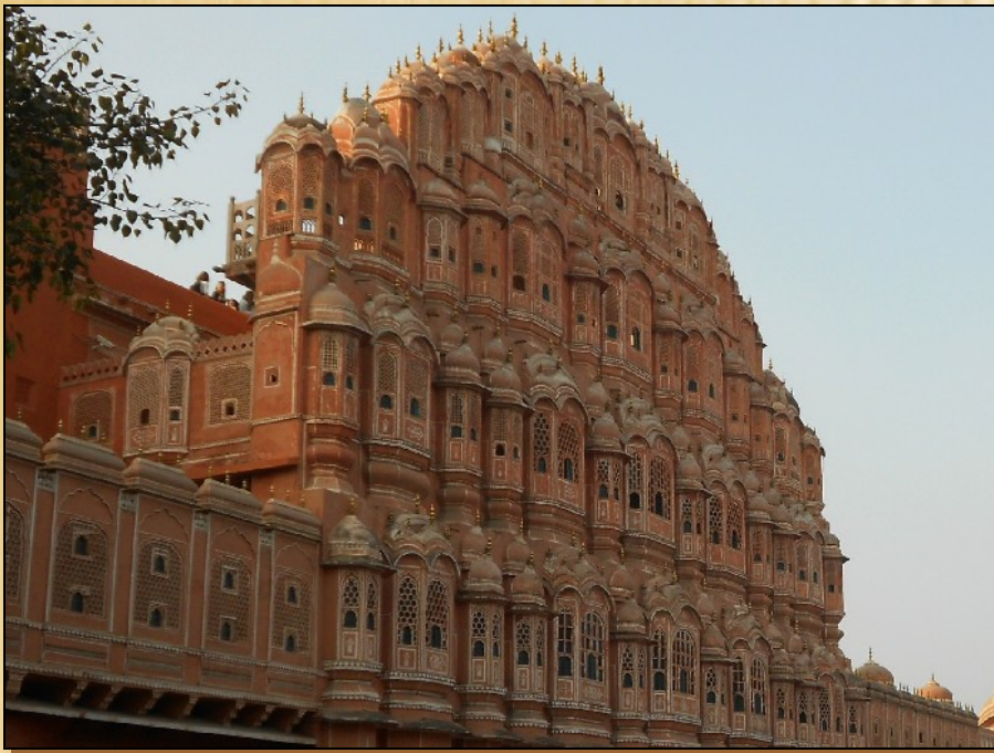
Der Palast der Winde in Jaipur: Viele Fenster für viele Geliebte...
